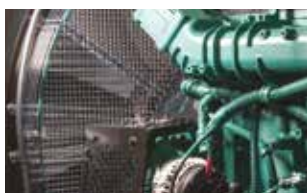
Protezione da contatti accidentali contro parti rotanti e mobili
